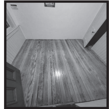
Foyer Douglas fir
